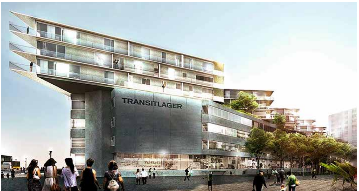
Das Transitlager im Dreispitz: Ein Beispiel für architektonische Akzente, die Münchenstein ein neues Gesicht geben.
