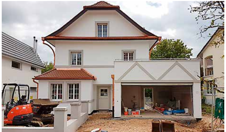
Umbau eines Hauses in der Gartenstadt.
