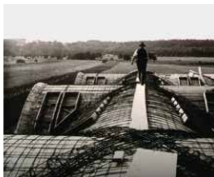
Die Haas'sche Schriftgiesserei im Bau
